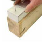
Abschluss- und Haltewinkel bündig am Unterprofil anlegen und vorbohren. Bohrdurchmesser 3 mm!
