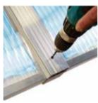
Nacheinander immer zwei Platten auflegen, ausrichten und fixieren. Kunststoffsteg durch die Bohrungen im Oberprofil vorbohren ( $\varnothing$  5 mm). Dann Profil und Steg mit Scobalit Edelstahlschrauben (Metall) 6,3 x 38 mm verschrauben.
