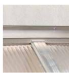
Schneiden Sie den Dichtgummi des Abschlusswinkels an den Profilen ein, damit er auf den Platten besser anliegt.
