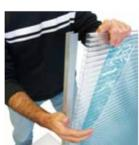
Montieren Sie dann an der Unterseite (Traufe) die Alu-U-Abschlussprofile mit Tropfnase nach unten. Die Schutzfolie wird dabei nur soweit entfernt wie es zur Befestigung nötig ist. Die gekennzeichneten Schutzfolien müssen nach außen gerichtet sein - UV-Schutz!
