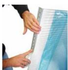
Bringen Sie das Kantenverschlussband am oberen Ende (Firstseite) der Platte an. Das Band verhindert das Eindringen von Staub, Schmutz und Insekten, lässt aber gleichzeitig die Durchlüftung der Hohlkammern zu.
