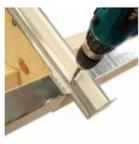
Vorbereitete Profilunterteile auflegen. Die Abschluss- und Haltewinkel können komplett überstehen (Wenn nicht möglich in den Sparren ausklinken). Profile exakt ausrichten, mit Zwingen fixieren und verschrauben.
